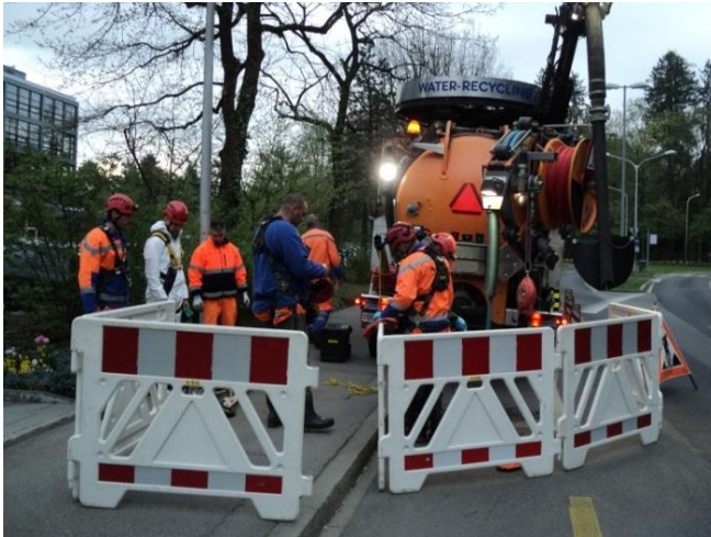
Abbildung 3 Abgesperrter & signalisierter Arbeitsbereich
