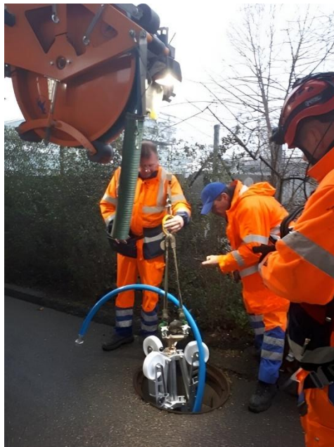
Abbildung 4 P360 wird in den Schacht hinuntergelassen
