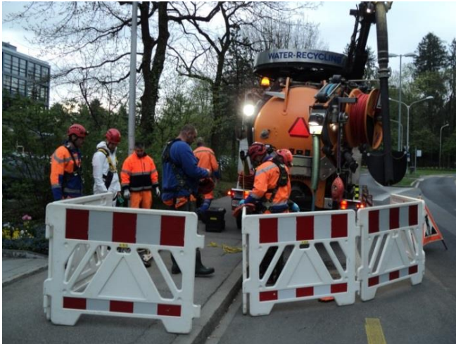
Abbildung 1 Abgesperrter & signalisierter Arbeitsbereich
