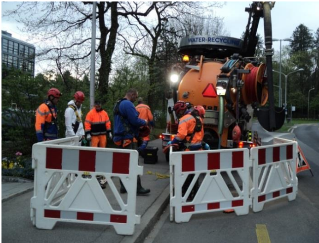
Abbildung 1 Abgesperrter & signalisierter Arbeitsbereich
