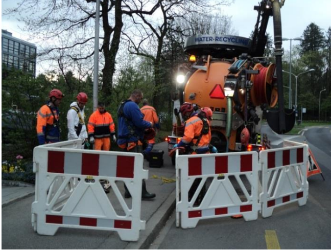
Abbildung 1 Abgesperrter & signalisierter Arbeitsbereich
