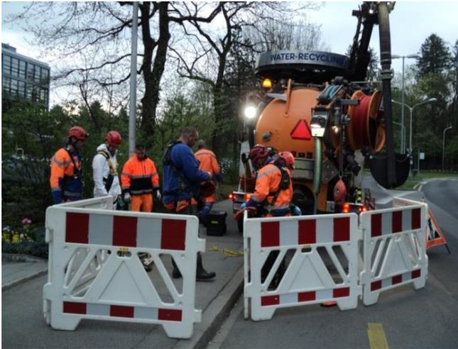
*Abbildung 1 Abgesperrter & signalisierter Arbeitsbereich*
