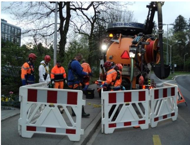
Abbildung 1 Abgesperrter & signalisierter Arbeitsbereich
