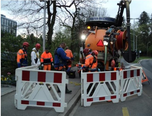
*Abbildung 1 Abgesperrter & signalisierter Arbeitsbereich*
