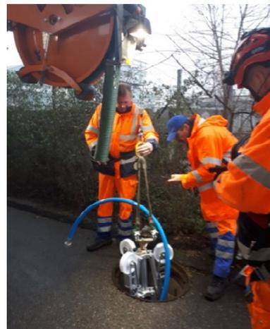
Figure 7 P360 sur le treuil
