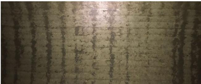
Figure 15 Formation de stries dans le conduit
