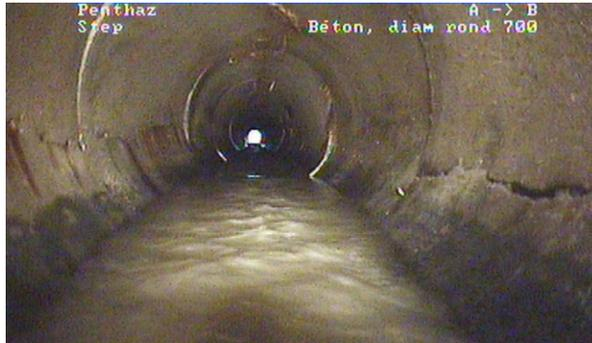
Figure 14 Paroi endommagée du conduit
