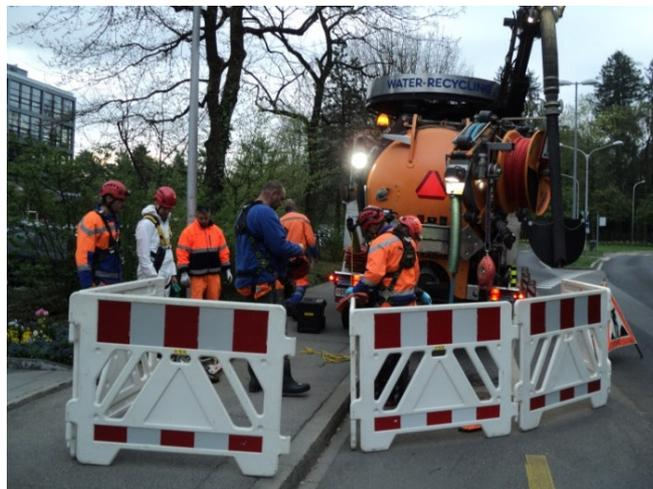
Figure 6 Zone de travail barrée et signalisée
