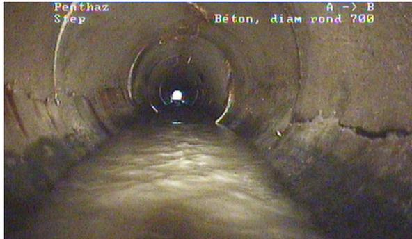
Abbildung 14 Beschädigte Rohrwand
