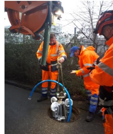
Abbildung 7 P360 an der Winde
