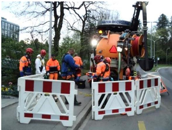
Figure 10: zone de travail clôturée et signalée
